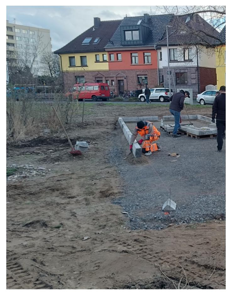
Wenn schon, dann machen Sie es richtig! Gestern setzte das Boule-Bahn-Team Randsteine, mit Betonmischer und Messgerät wurde Stein um Stein akkurat einbetoniert.
