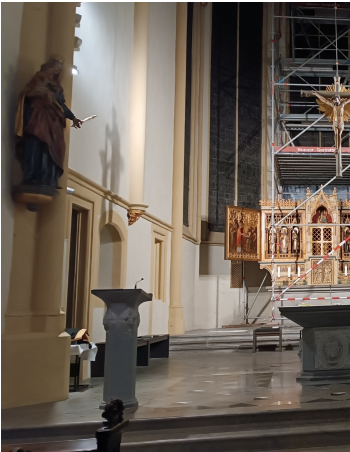
Kommenden Montag oder Mittwoch (11.12./13.12.) wird das Gerüst im Chorbereich der Servatiuskirche (ohne Reparatur des defekten Fensters) abgebaut.
