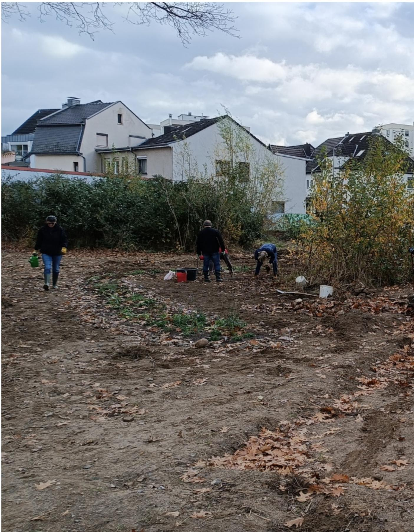
Der Aushub für die geplante Boule-Bahn wurde vom Laub befreit - am Montag kommt der frostsichere Schotteruntergrund.
