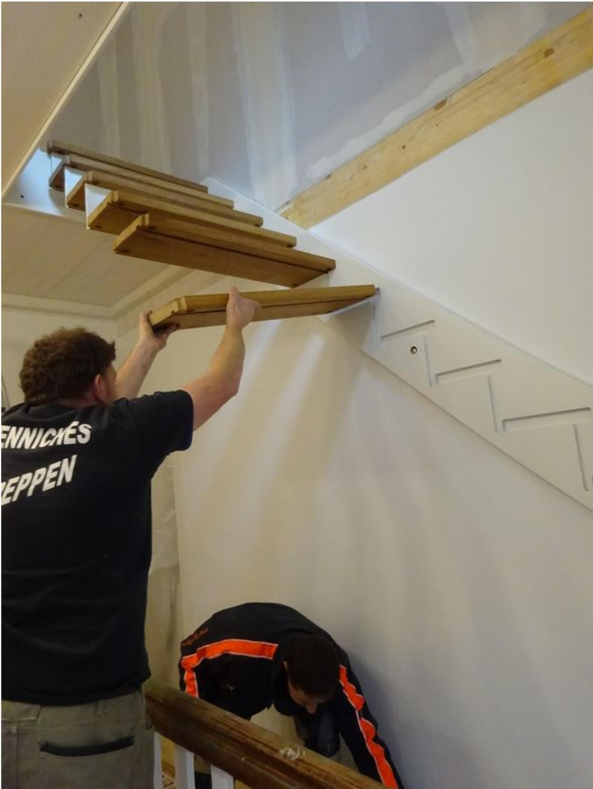
Die Einzelteile wurden in einem exakt vorbereiteten Bausatz angeliefert. Die Führungsschiene an der Wandseite wurde zuerst angebracht, dann die einzelnen Stufen eingesetzt.
