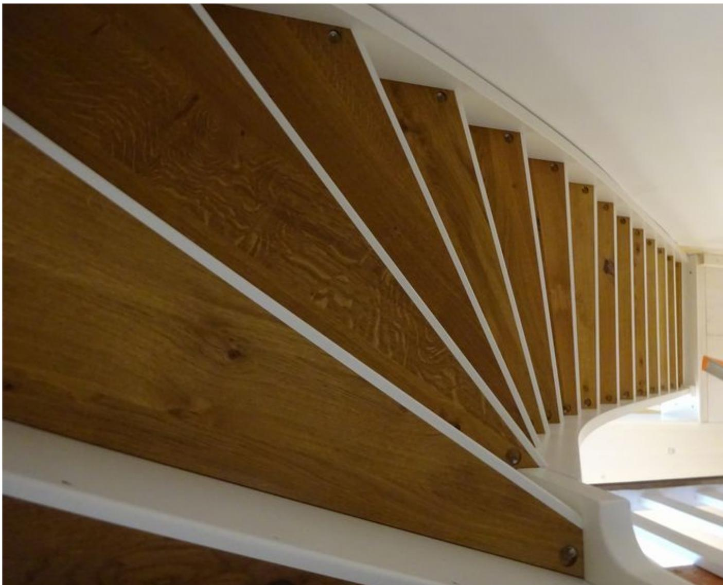
Zuletzt wurde die wandabgewandte Seite (Führungsschiene und Verkleidung in einem) montiert. Die komplette Treppe war in nicht einmal vier Stunden montiert!
