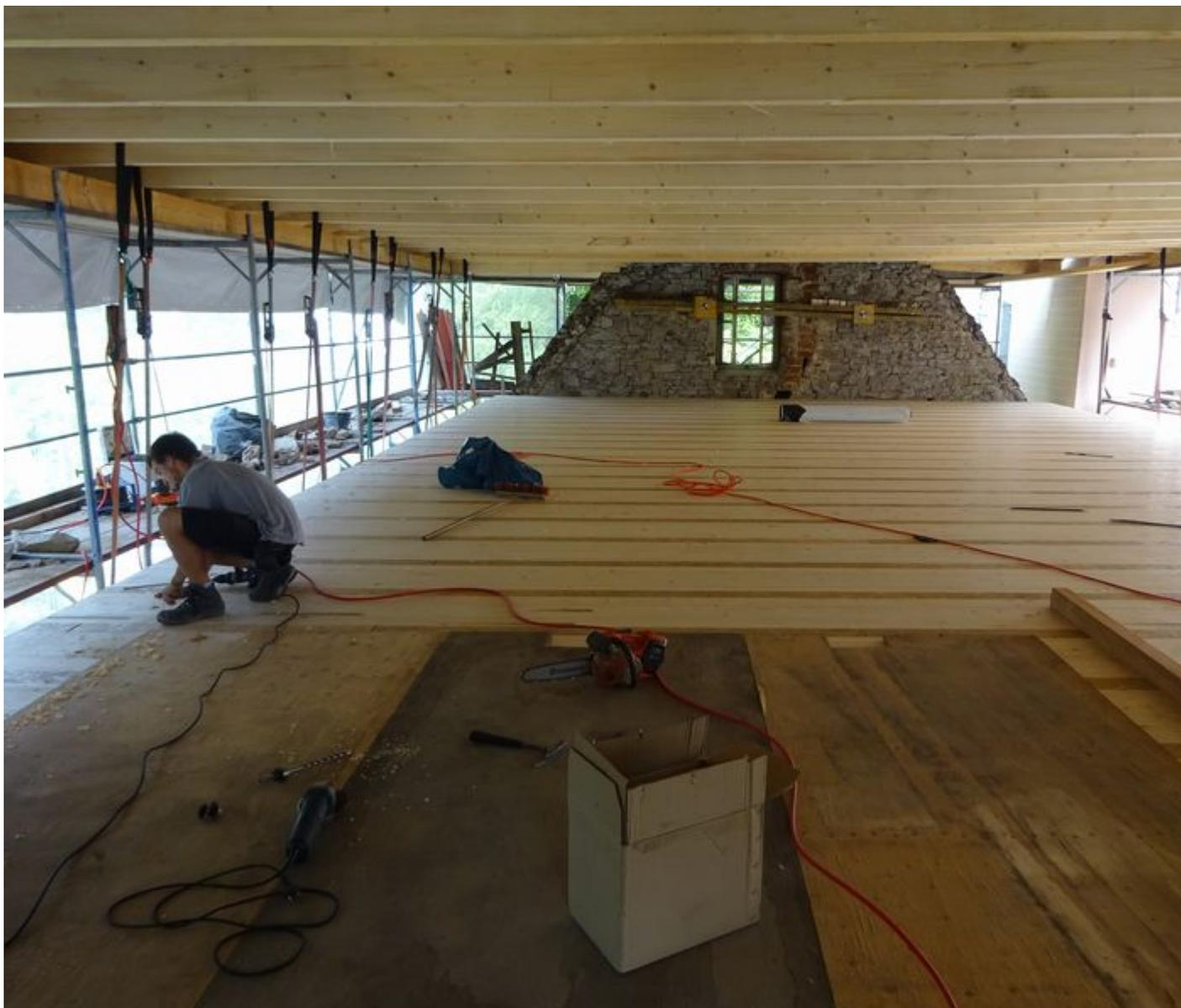
Die Decke oben ist bereits fertig, sie ist der Fußboden des Dachgeschosses. Jetzt werden noch die Planken für den Boden des 1. Obergeschosses verlegt.
