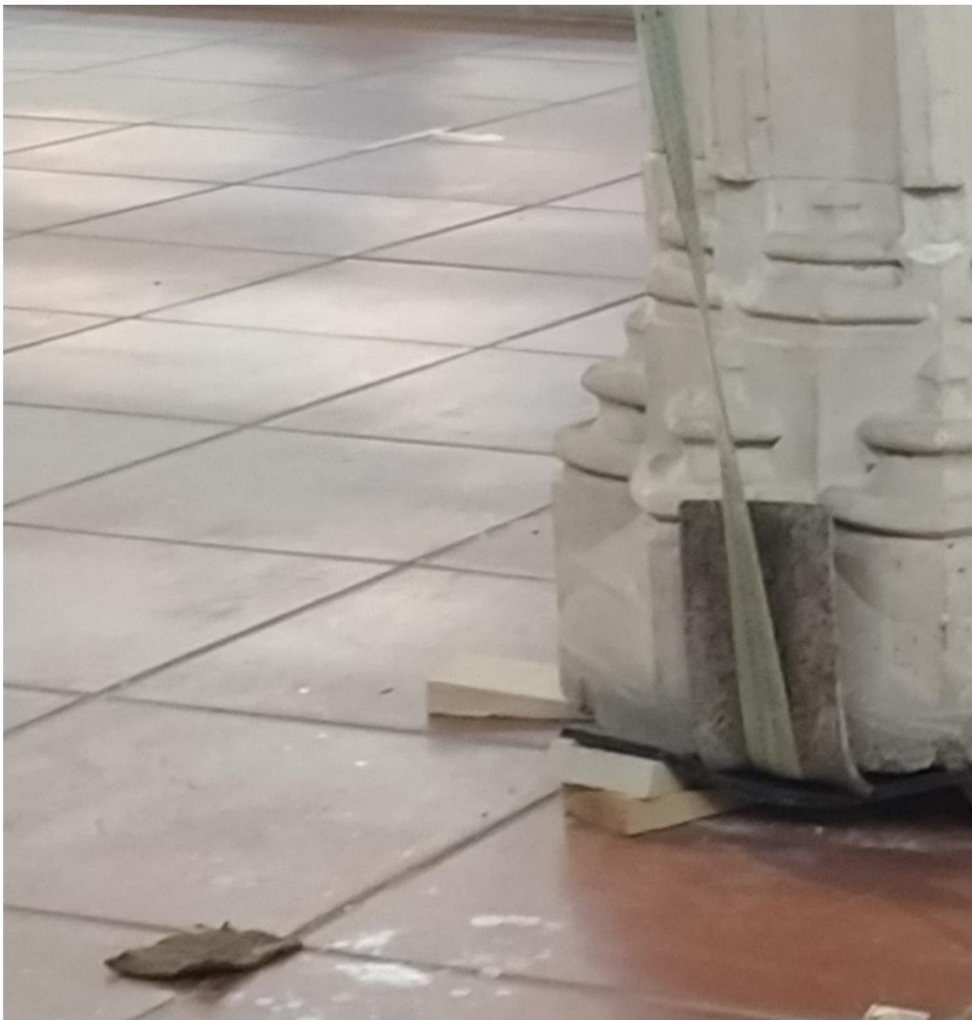
Mit Keilen wurde das schwere Becken, das eigentlich aus drei Teilen besteht, aufgelagert; immer wieder eine Schicht höher, bis schließlich die 8 cm erreicht waren, um den Hubwagen darunter zu fahren. Zuvor war es mit Spanngurten befestigt worden; möglichst eng, damit die Mittelkante keinen Druck abbekam.
